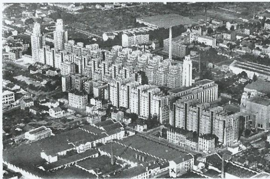
L'usine Dognin-Isaac à côté des Gratte-Ciel
